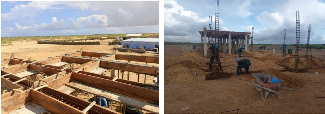
Ilustración 17 Perforación de Pozo Centro de Producción Los Cocos.
