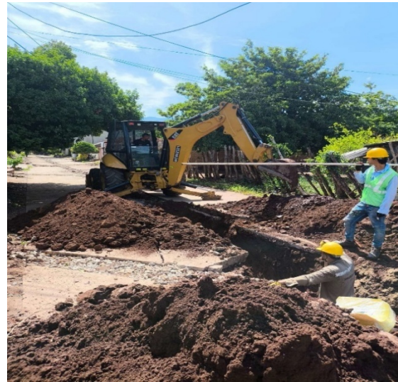
Excavaciones para suministro e intalacion de tubería sanitaria en el Municipio del Molino
