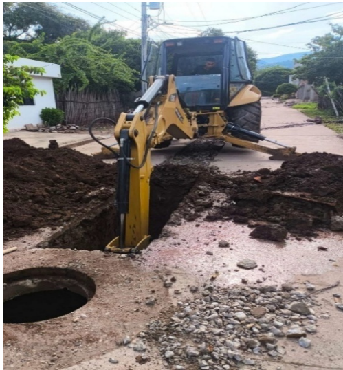
Excavaciones para suministro e intalacion de tubería sanitaria en el Municipio del Molino
