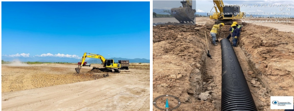
Ampliación del sistema de tratamiento de aguas residuales del municipio de san juan del cesar
