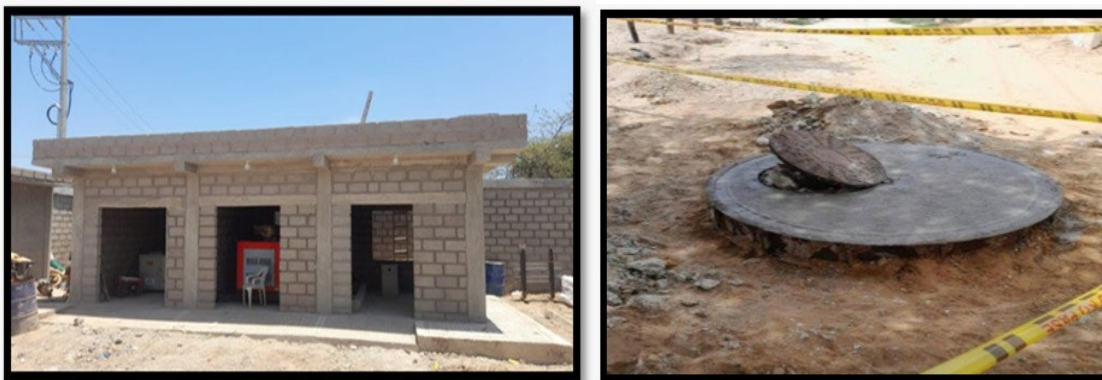
Ilustración 7 Ampliación de las redes de alcantarillado en el barrio Villa Fátima
