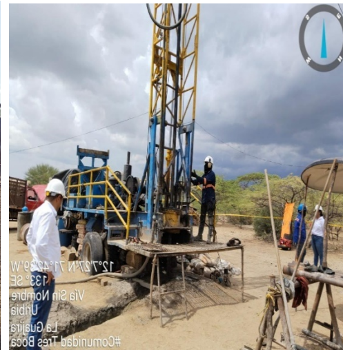
Ilustración 17 Perforación de Pozo Centro de Producción Tres Bocas.
