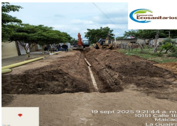
Ilustración. Excavaciones con entibados e instalación de tuberías de alcantarillado.
