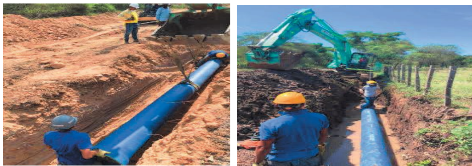
Ilustración 20 Construcción de línea de aducción desde la válvula ADR de la represa del río Ranchería de la PTAP del municipio de San Juan Del Cesar.
