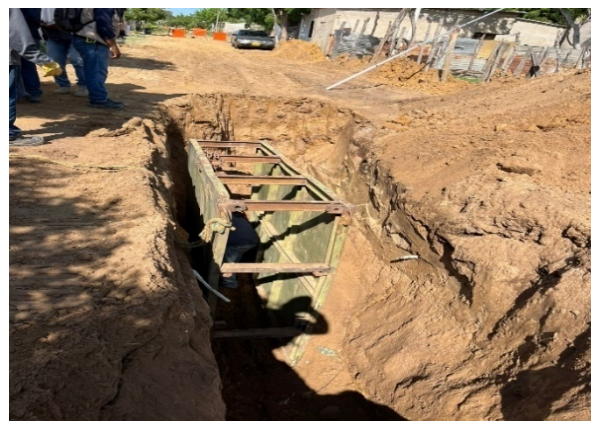
Ilustración. Excavaciones con entibados e instalación de tuberías de alcantarillado.
